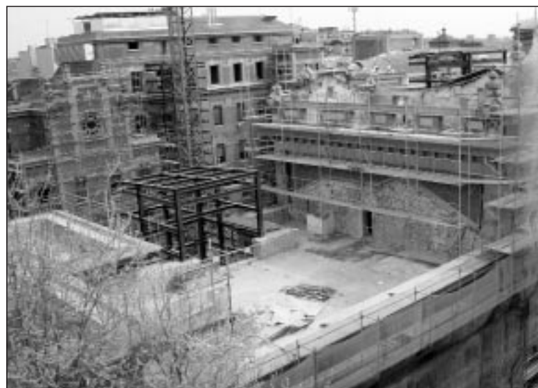
Las antiguas cubiertas ya han sido demolidas y se trabaja en la construcción de las nuevas para avanzar en la reforma interior.
