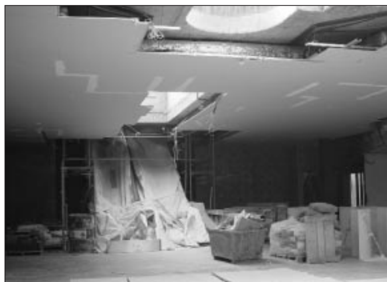
Vista de las obras de la nueva Recepción del Hospital, situada bajo el jardín. Al fondo, las escaleras mecánicas de acceso.
